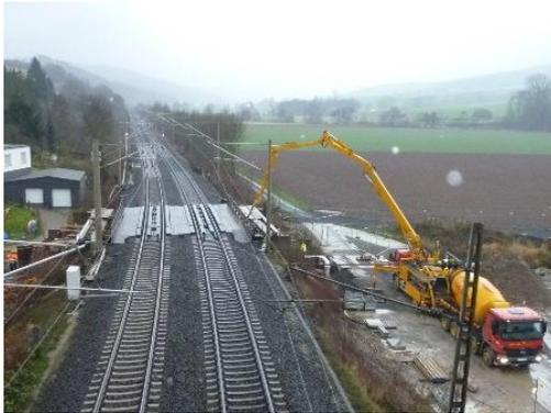
**Bild 1:** Betonieren unter Hilfsbrücken [1]
