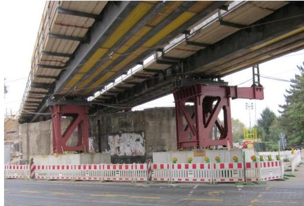
**Bild 1:** Herstellung Querverbau [1]    **Bild 2:** Hilfsbrückenkette auf Behelfsstützen [1]
